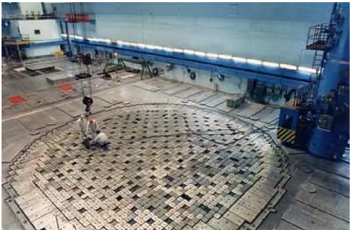
Rys. 9. Prace montażowe na górnej płycie reaktora ( www.rosenergoatom.ru )
